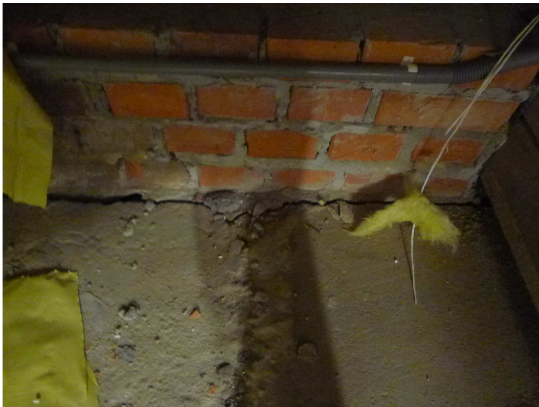
fot. 11 Pęknięcie - odspojenie stropu od ściany zewnętrznej
