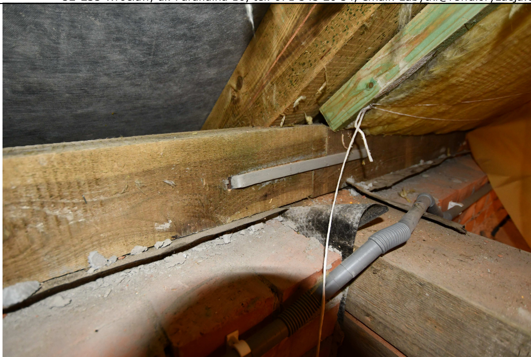
fot. 5 Widok oparcia krokwi na murłacie
