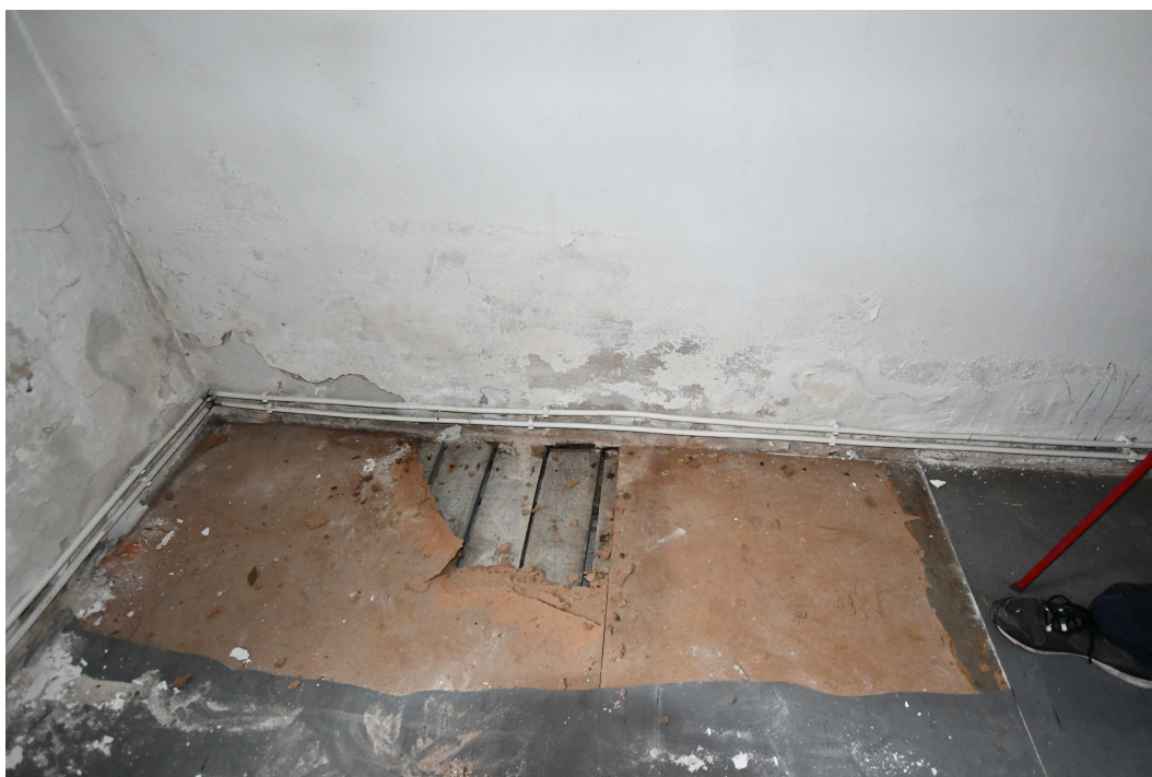
fot. 10 Odkrywka posadzki w aneksie wschodnim (projektowane biuro)
