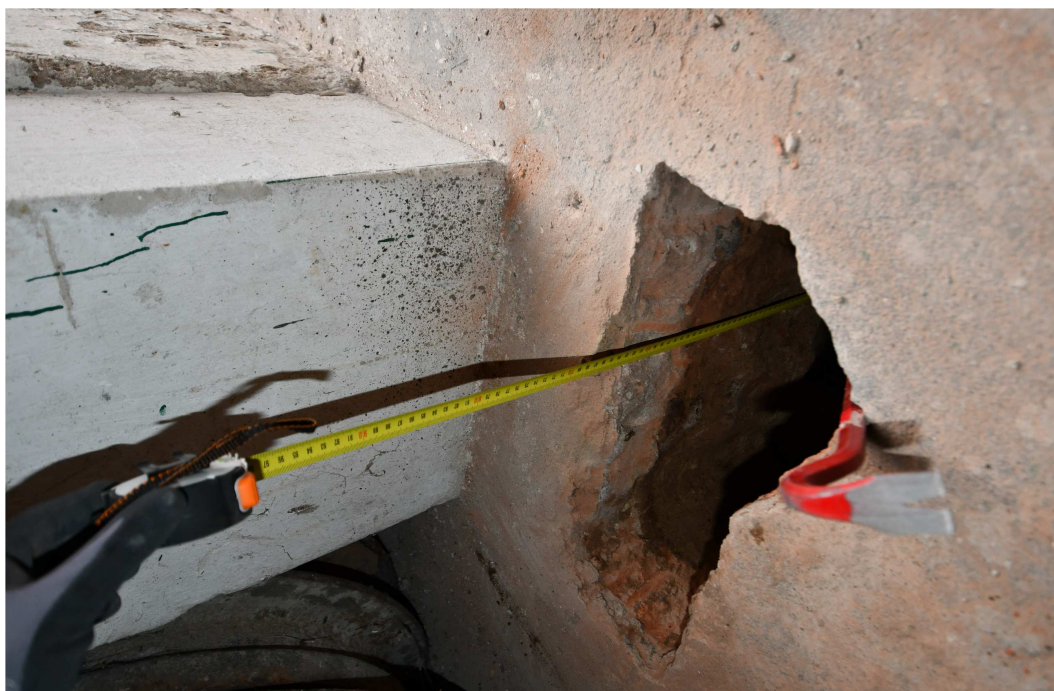
fot. 1 Odkrywka posadowienia ceglanego pilastru przy północnej ścianie budynku
