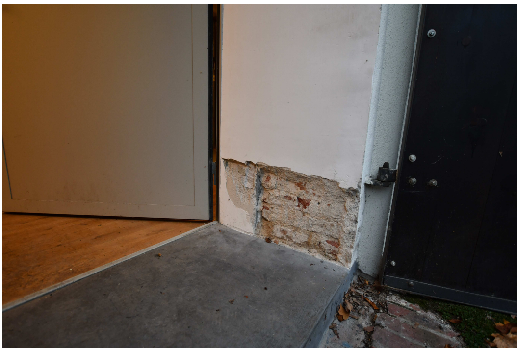
fot. 4 Widok styku ściany zewnętrznej i dostawionej od wewnątrz ściany
