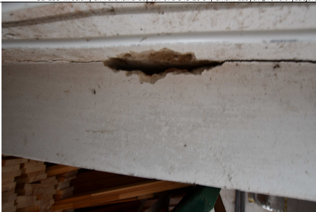
fot. 3 Styk ceglanego filara i ściany zewnętrznej
