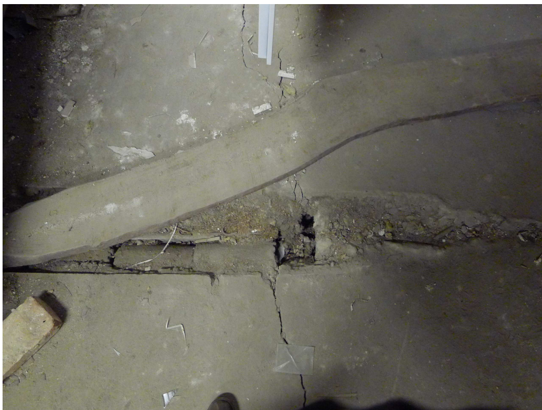
Fot. 12 Niezabetonowane pustaki typu DZ
