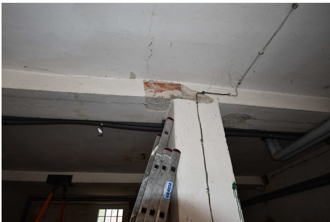
fot. 2 Odsłonięte belki stropu DFZ-3 tworzące podciąg w centralnej części budynku (4 szt).
