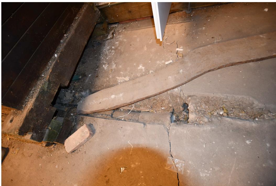
fot. 8 Miejsce ubytku nadbetonu w stropie oraz podłużne pęknięcie wzdłuż podciągu
