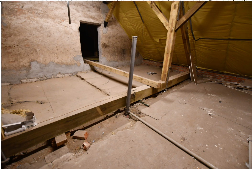
Fot. 7 Pozostawione kliny pod belką więzara nad pom. małej stajni
