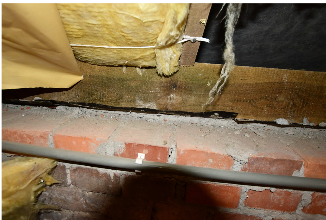
fot. 6 Spękania zaprawy pod murłatą znamionujące jej obrót w kierunku zewnętrznym
